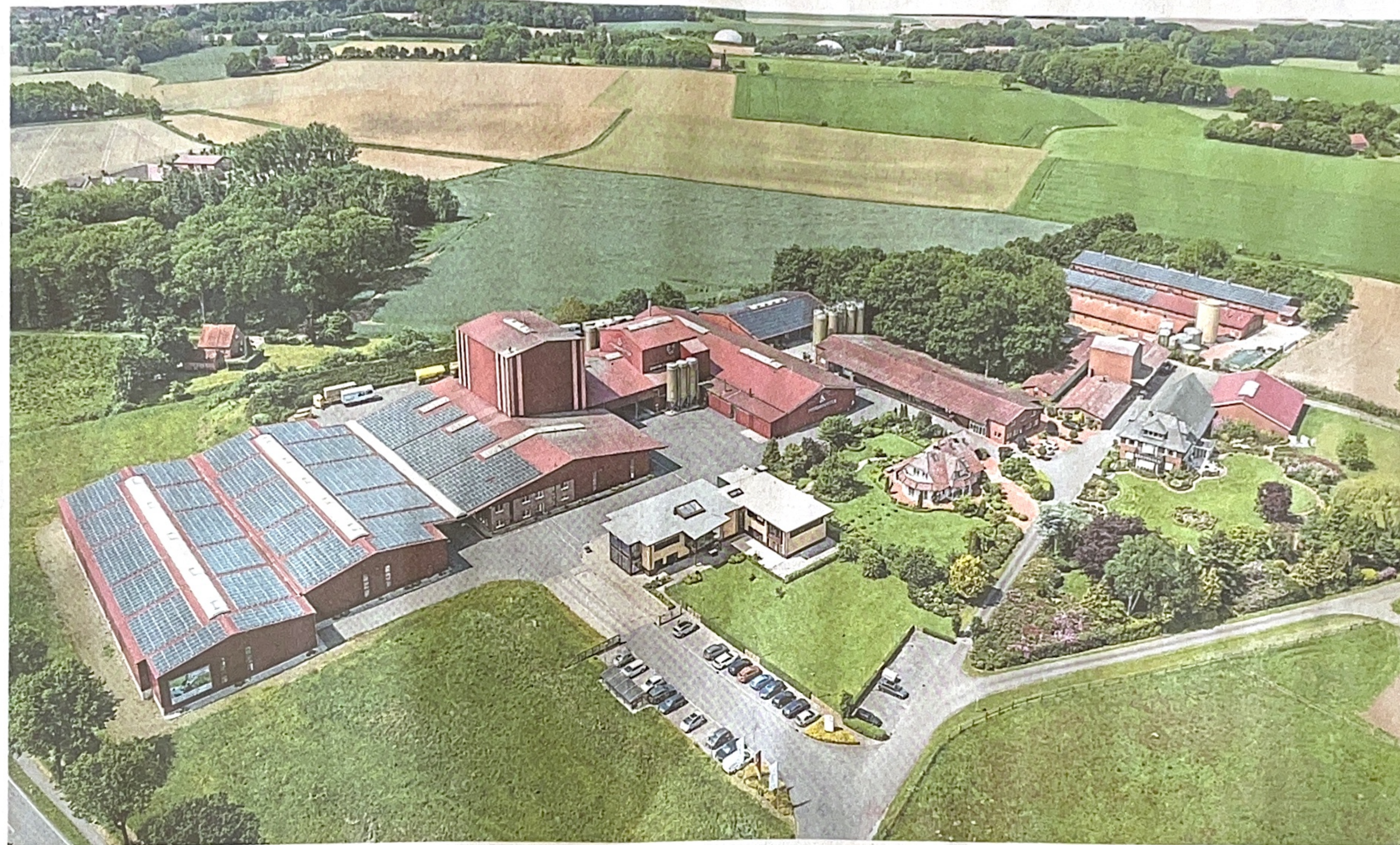
Blick von oben auf das Firmengelände in Hastrup: Die Bernhard Kreiling GmbH & Co. KG investiert hier in den Bau eines dritten Werks.
